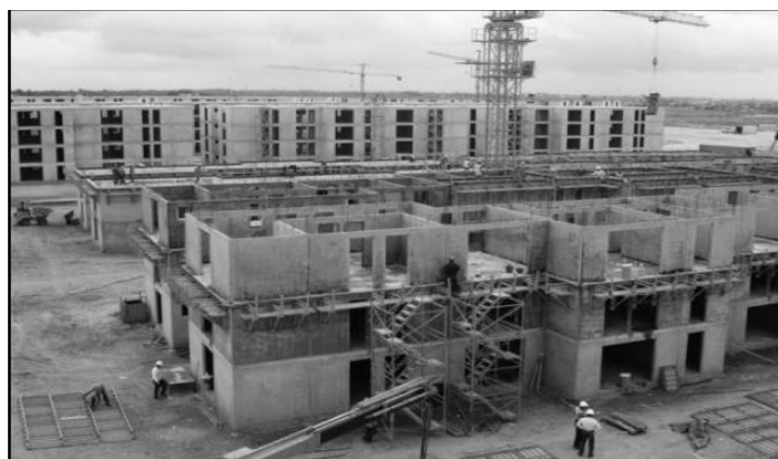
تصویر : ۱-۳- سیستم دارای دیوار برشی منسجم
