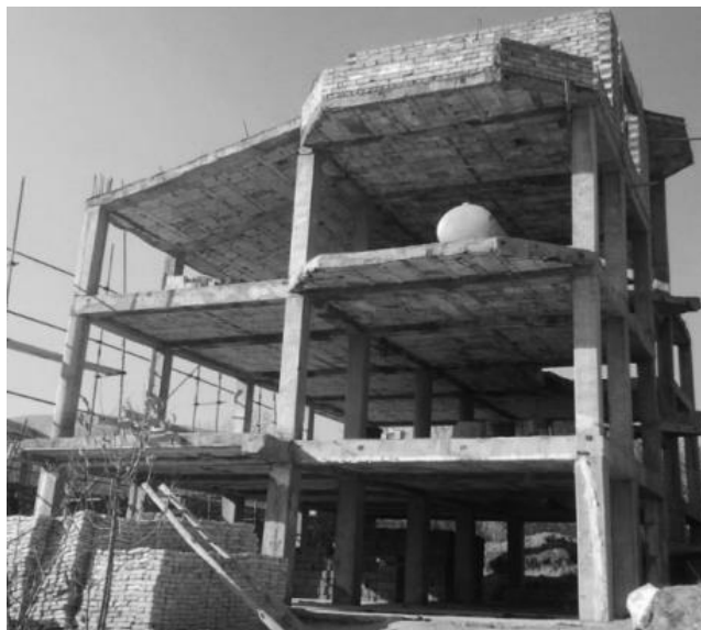
تصویر : ۱-۲- سیستم قاب نیمه صلب بتنی
