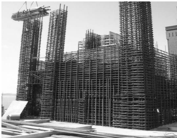
تصویر: ۱-۵- سیستم قاب و دیوار برشی
