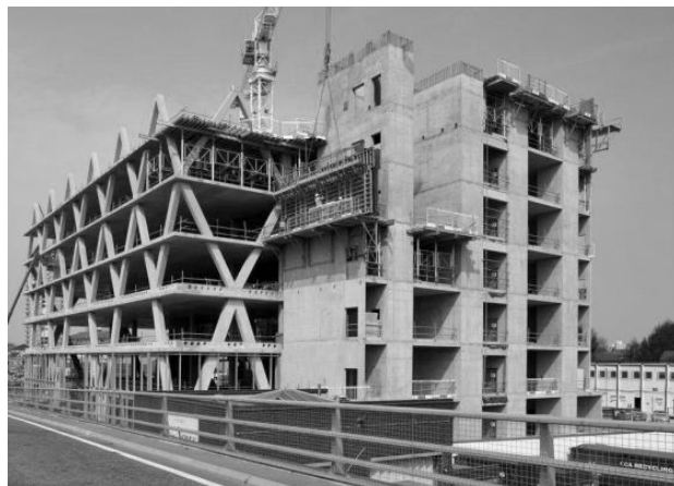
تصویر: ۱-۶- سیستم قاب مفصلی و صلب و دیوار برشی
