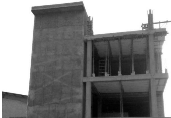
تصویر : ۱-۴- سیستم قاب مفصلی ( نیمه صلب ) و دیوار برشی
