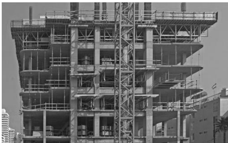
تصویر : ۱-۱- سیستم قاب خمشی بتنی
