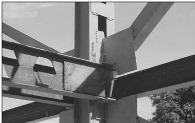
تصویر : ۱-۲- سیستم قاب ساده خورجینی به انضمام مهاربند CBF
