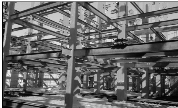
تصویر : ۱-۱- سیستم قاب خمشی فولادی
