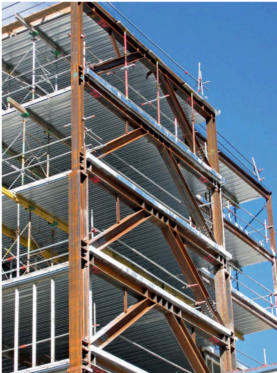
شکل ۱-۴. ج) مثالی از یک نوع سیستم سازه‌ای: قاب مهاربندی شده و اگر
