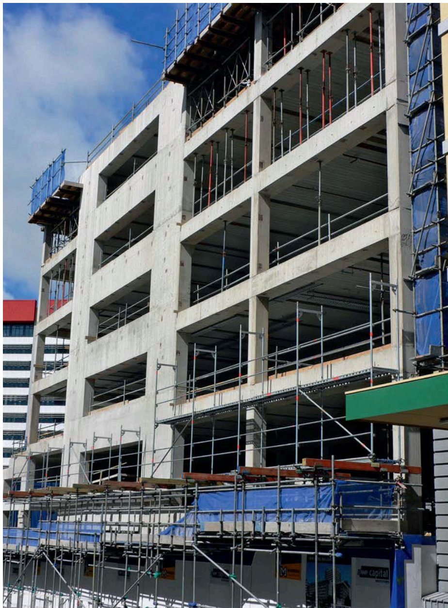
شکل ۱-۴. ب) مثالی از یک نوع سیستم سازه‌ای: قاب خمشی
