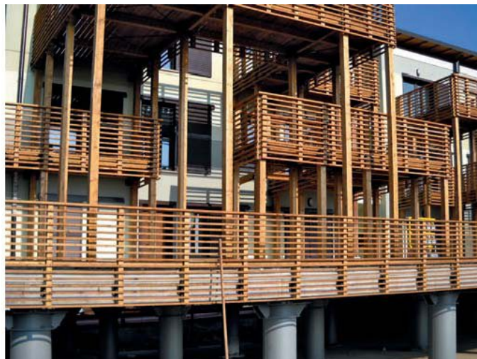
شکل ۲-۸. بخش یک از ۱۸۵ ساختمان مسکونی که به عنوان قسمتی از پروژه C.A.S.E. ۱ بعد از زلزله سال ۲۰۰۹ لاکوئلا ۲ در ایتالیا ساخته شدند. این ساختمان‌های چند طبقه بر روی دال‌های هم‌کف جداسازی شده در بالای زیرزمین‌ها، ساخته شده‌اند.
