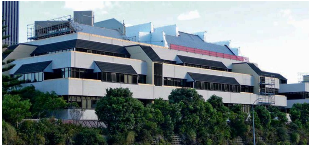
شکل ۱-۲. ساختمان ویلیام کلیتون، ولینگتون، نیوزیلند، ۱۹۸۱. اولین مثال از کاربرد جامع روش جداسازی لرزه‌ای.
