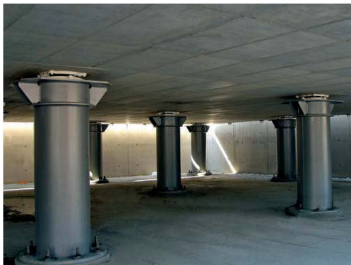
شکل ۲-۹. زیرزمین با کاربری پارکینگ در یک ساختمان از پروژه C.A.S.E. لغزنده‌های با سطوح مقعر دو قوسی، دال طبقه هم‌کف را از ستون‌های طره‌ای جدا می‌کنند.
