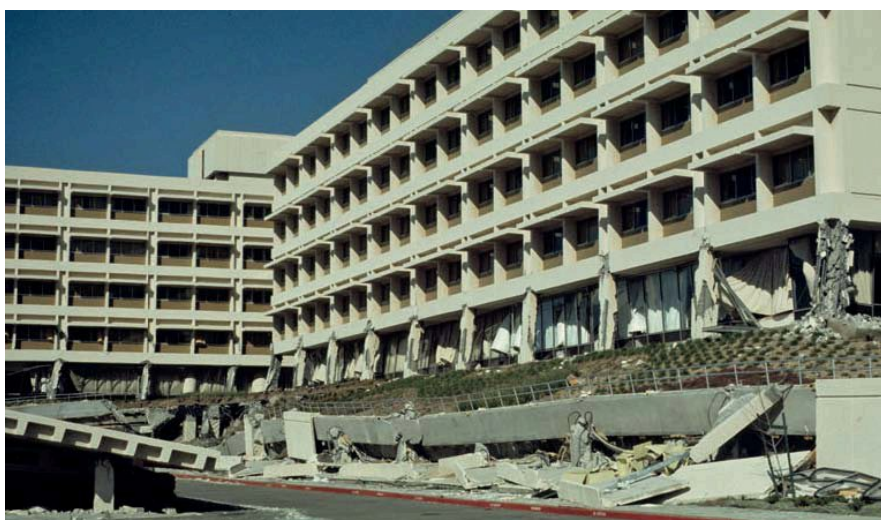
شکل ۱-۲. بیمارستان الیو ویو ۳ که ساختمانی دارای قاب خمشی است و به شدت خسارت دیده است. زلزله دره سن فرناندو ۴ ، کالیفرنیا، ایالات متحده، ۱۹۷۱.
